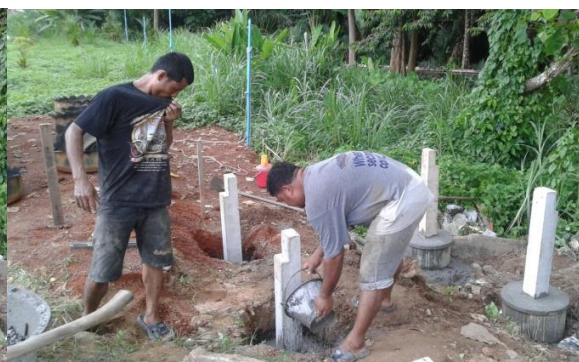
ภาพที่ 10 แสดงการสร้างสิ่งก่อสร้างภายในศูนย์เรียนรู้
