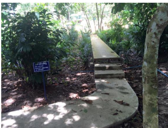
ภาพที่ 26 ลักษณะเส้นทางเดินและสะพาน
