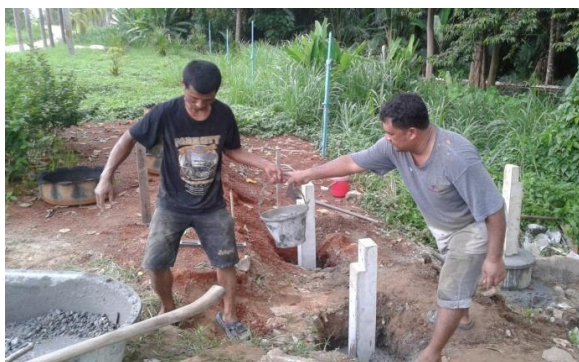
ภาพที่ 9 แสดงการสร้างสิ่งก่อสร้างภายในศูนย์เรียนรู้
